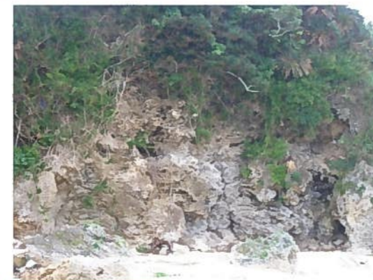
自然崖 崩壊状況
