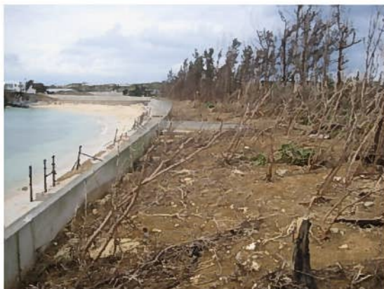
墓地海側保安林 被災状況
