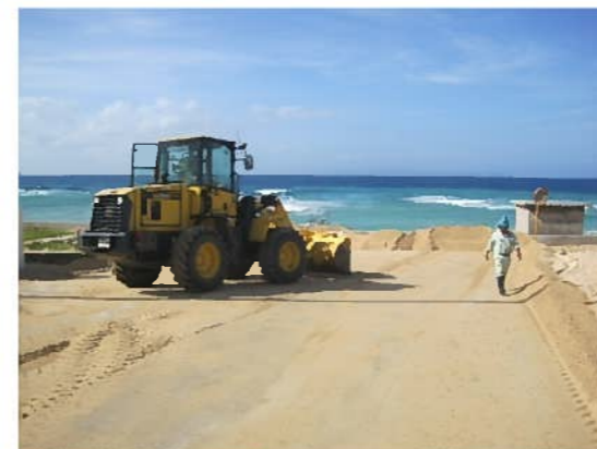
堆積砂の撤去状況
