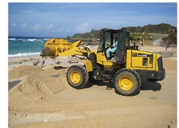
堆積砂の撤去状況
