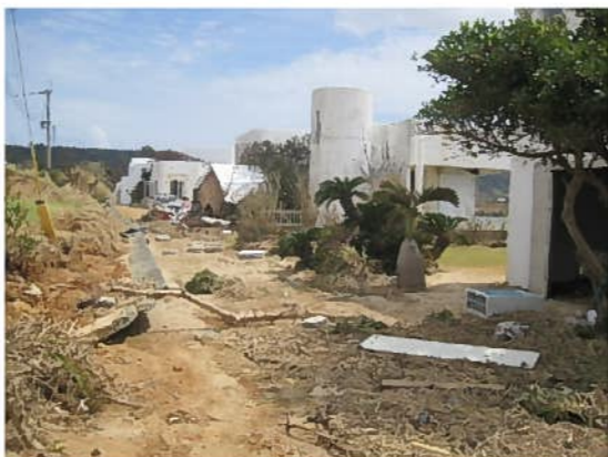
人家裏道路 被災状況
