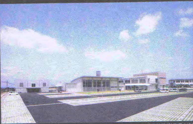
東側外観(駐車場より)
