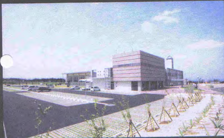
東側外観(前面道路より)
