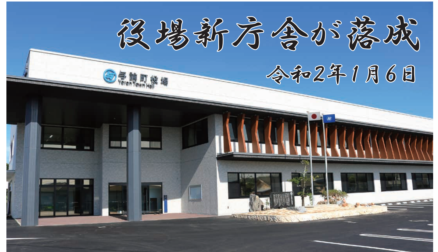
▲庁舎の外観は、白い砂浜をイメージした外装タイルと、波の波形を連想させる木製ルーバーでデザインされた
