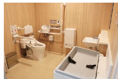
1階 多機能トイレ (ベビーシート設置あり)
