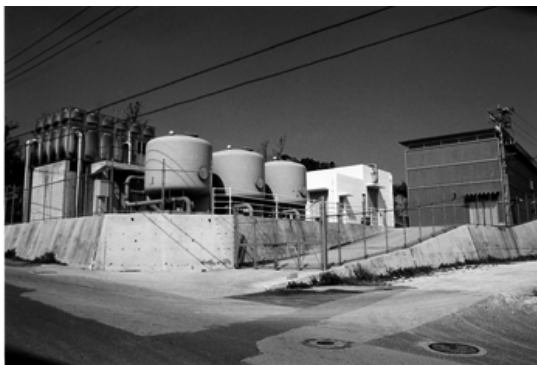
淡水化施設(平成13年供用開始)
