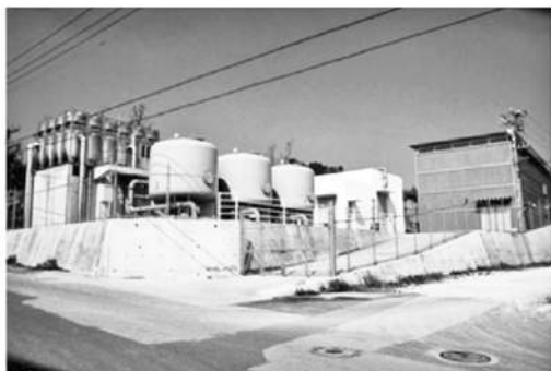
淡水化施設(平成13年供用開始)
