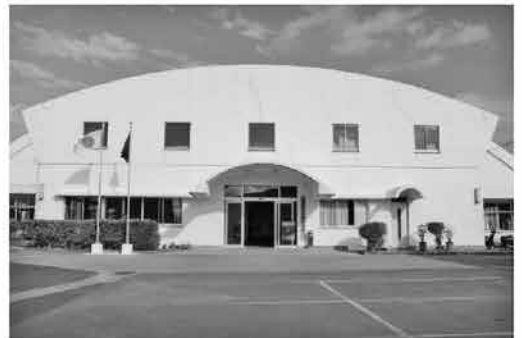
役場機能を仮庁舎（屋内多目的運動場）等に分散
