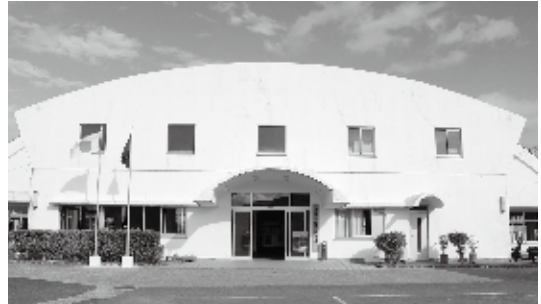
役場機能を仮庁舎（屋内多目的運動場）等に分散
