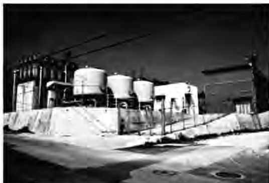
淡水化施設(平成13年供用開始)
