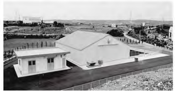
最終処分場完成
