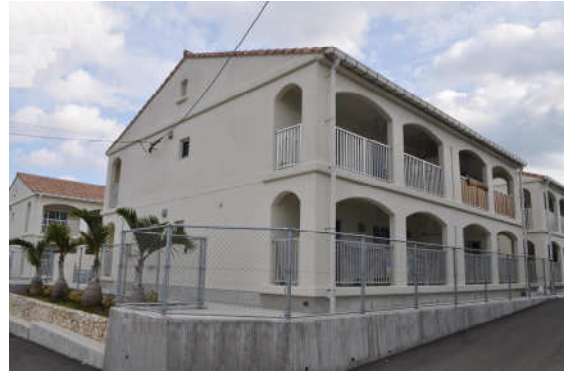
宇和寺住宅4号棟完成
