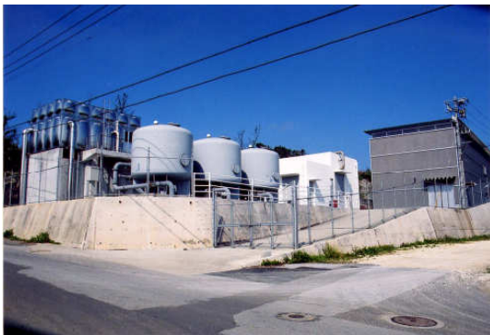
淡水化施設(平成13年供用開始)
