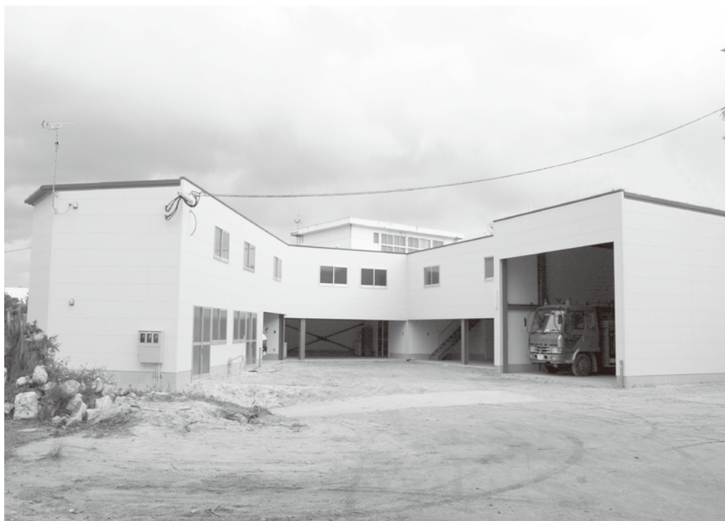
役場南庁舎別館完成
