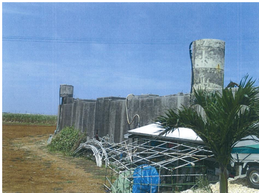
写真 3.1 し尿貯留施設
