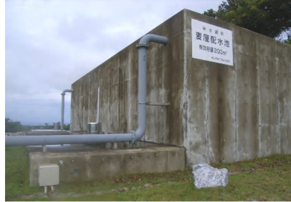
麦屋配水池（鉄筋コンクリート造）
