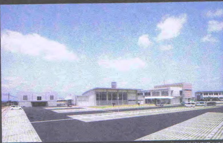
東側外観(駐車場より)
