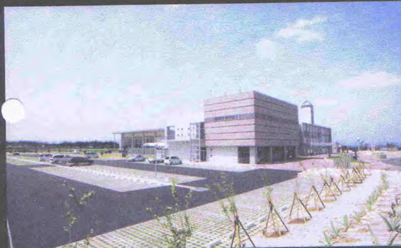
東側外観(前面道路より)
