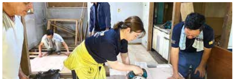
住まいるプロジェクト作業風景
