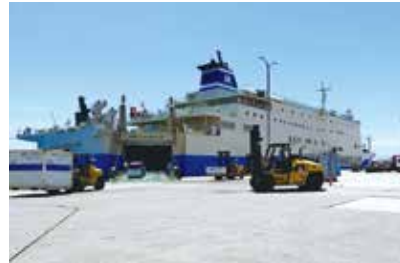
供利港岸壁の現状
