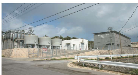
老朽化した浄水場
