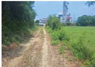
未舗装の町道高校線
