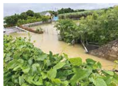
空港トンネル北側
