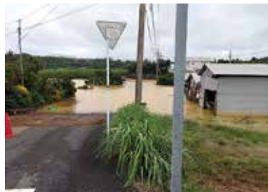
東与舎ため池周辺
