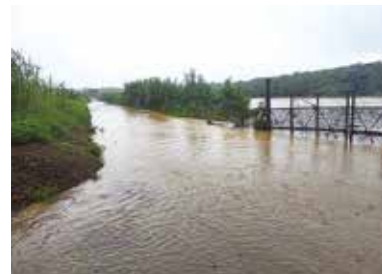
東与舎ため池周辺
