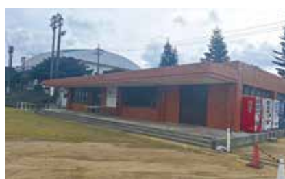
総合グラウンド管理棟
