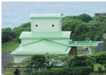
改修工事を終えた火葬場
