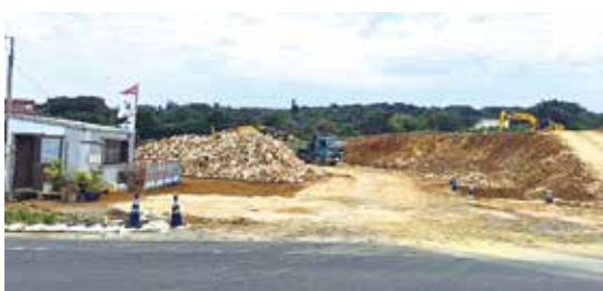
工事中の浸透池
