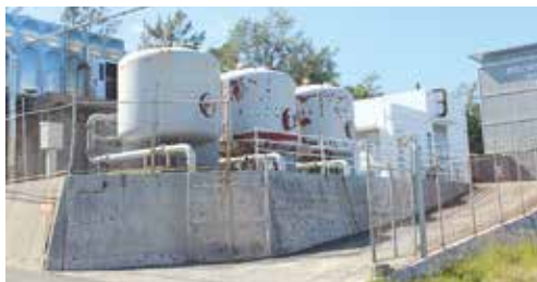
更新が待たれる古里浄水場
