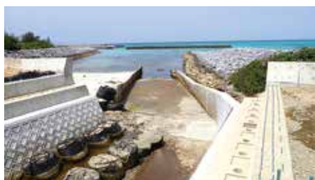
早期完成が待たれる兼久橋
