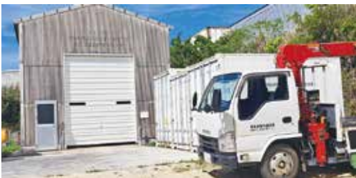
老朽化した死亡獣畜処理センター
