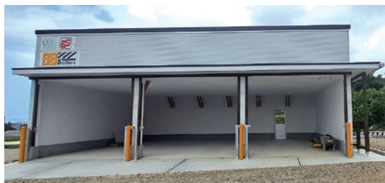
建設中の防災倉庫
