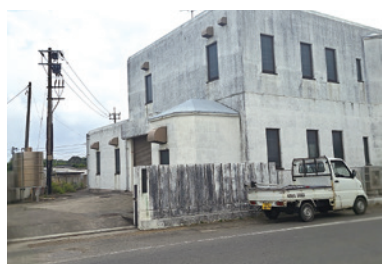
農業集落排水処理施設
