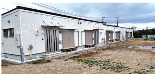
整備された叶住宅
