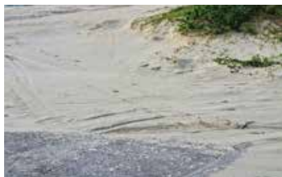
砂に埋もれた船倉の船揚場
