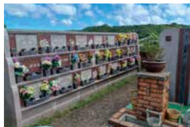
屋外に建設された納骨壇
