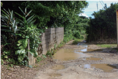
田畑線(仮称)の要整備道路
