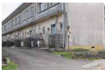
改修予定の瀬良座住宅
