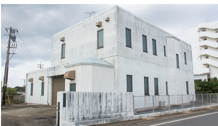
農業集落排水施設
