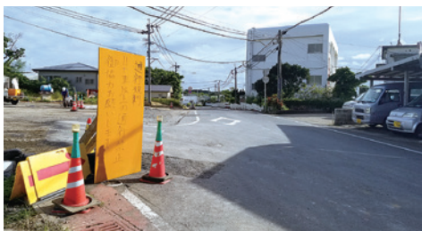
工事中の茶花小学校前交差点
