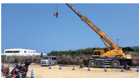
新庁舎建設現場（旧診療所跡地）
