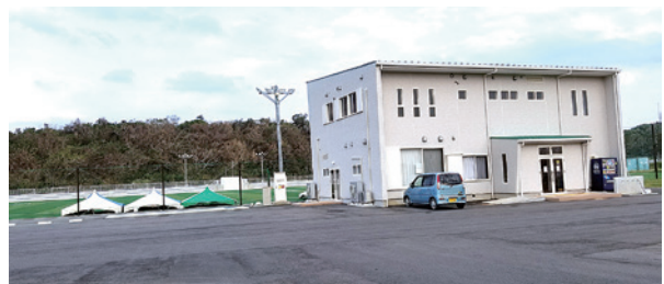
多目的運動広場のクラブハウス
