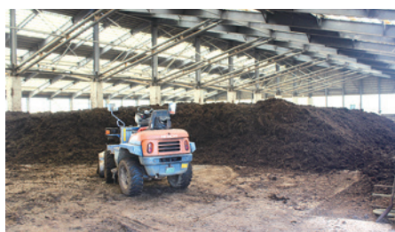
改善が待たれる堆肥センター
