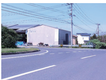
閉鎖されている県道
