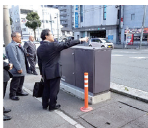
トランスケースの調査
