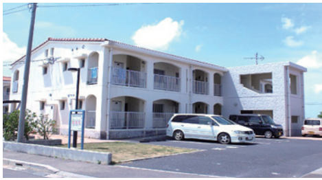
宇和寺県営住宅
