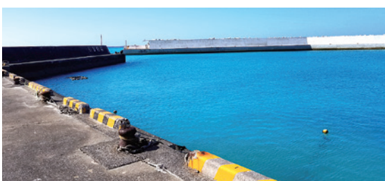
航路の浚渫が望まれる茶花漁港
