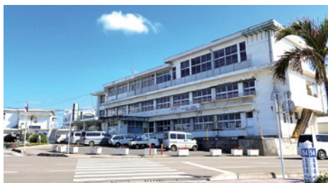
取り壊しを待つ旧役場庁舎
