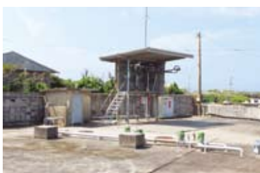
石油備蓄タンク（地下）
