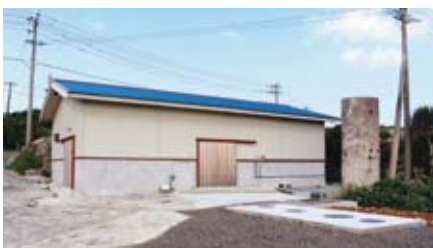
浄化槽が設置されたと畜場
