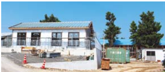
矢口団地の住宅建設現場
