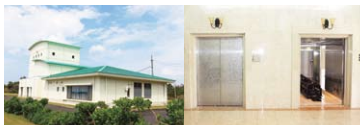
火葬場と増設された炉（右側）
