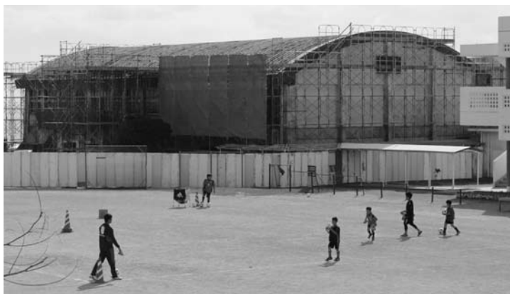
与論小学校体育館の改修工事
