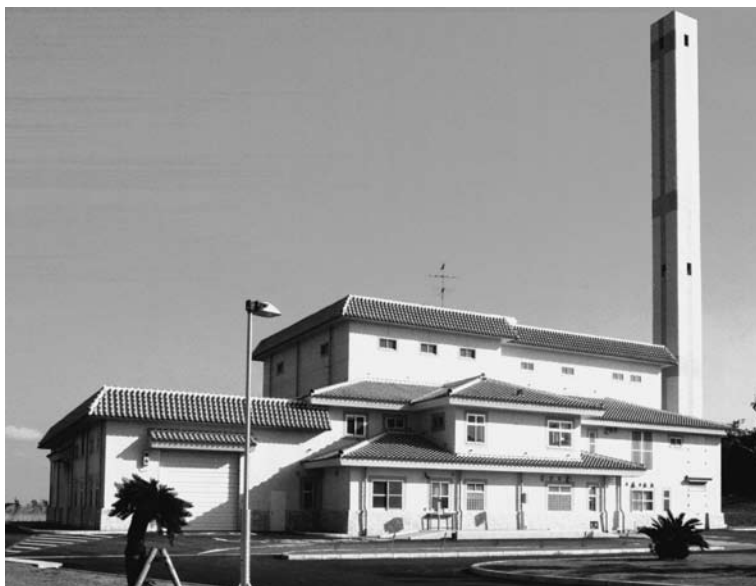
伊江村清掃センター (E&Cセンター)
