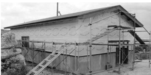
建設中のと畜場
