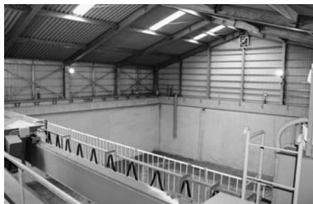
完成した最終処分場
