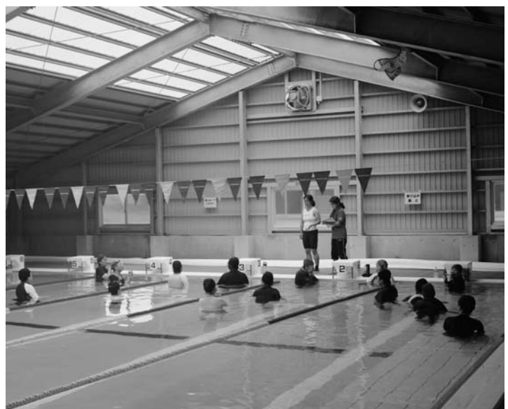
完成した温水プール
