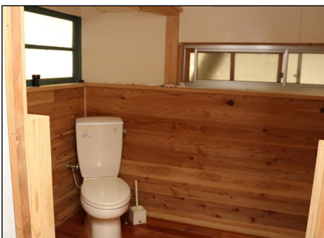
1階西側 トイレ
